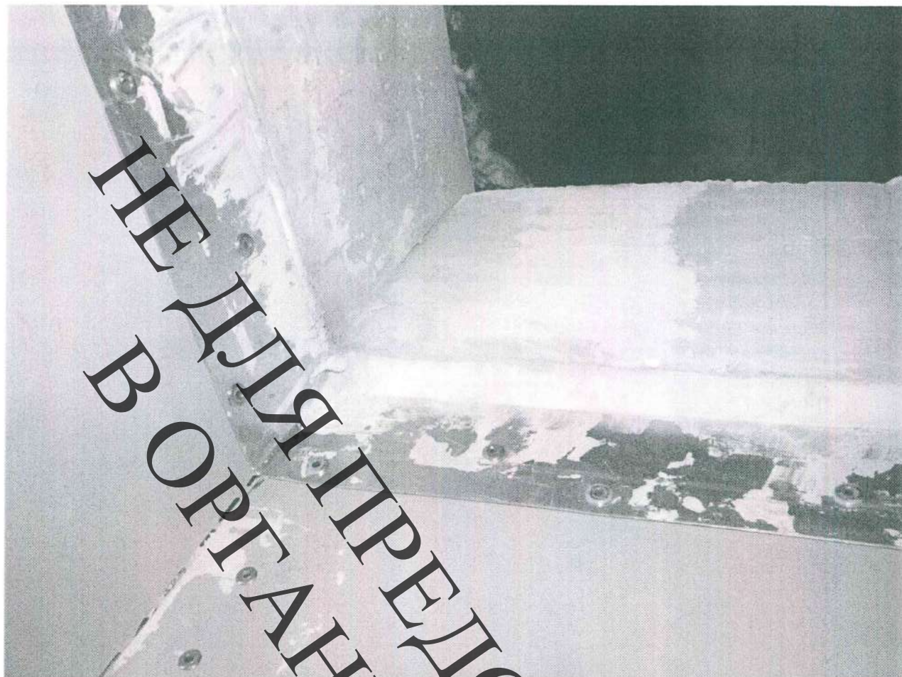
Фото 6. Устройство обрамлений оконных проемов, монтаж откосов (нижний угол оконного обрамления).
